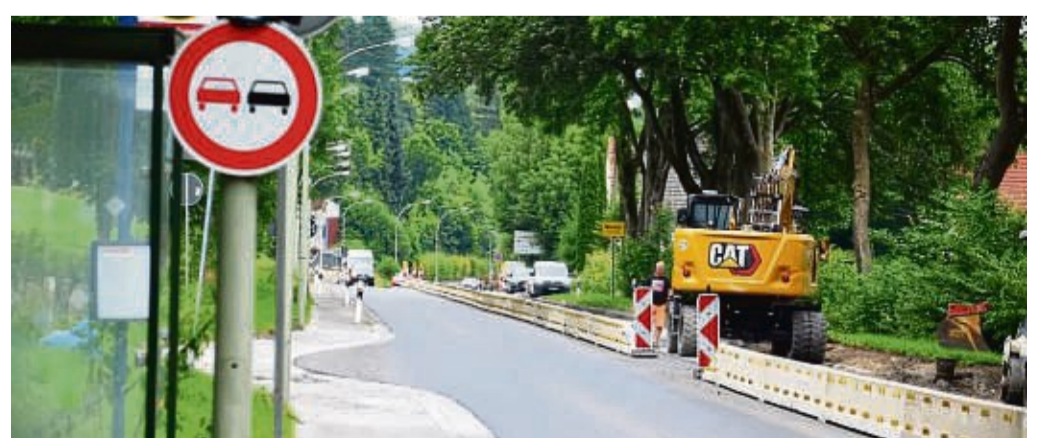
Die Fahrbahnverschwenkung der neuen Querungshilfe am südlichen Ortsausgang ist bereits zu erkennen.
