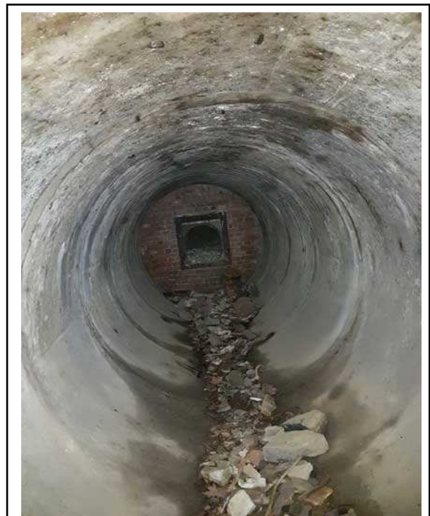
Der alte Röhrenbunker an der ehemaligen WLE-Bahntrasse mit Notausstieg
