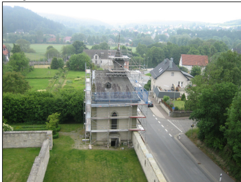
Die Kapelle im Gerüst wie 1868
