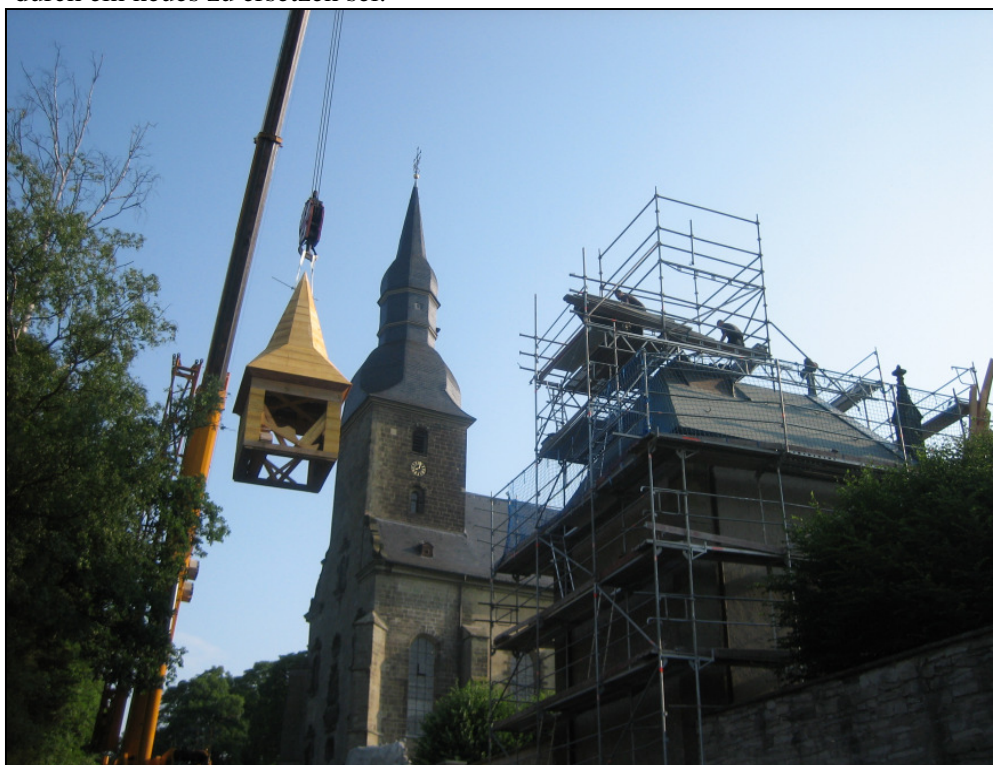
Aufsetzen der neuen Turmhaube 2009
