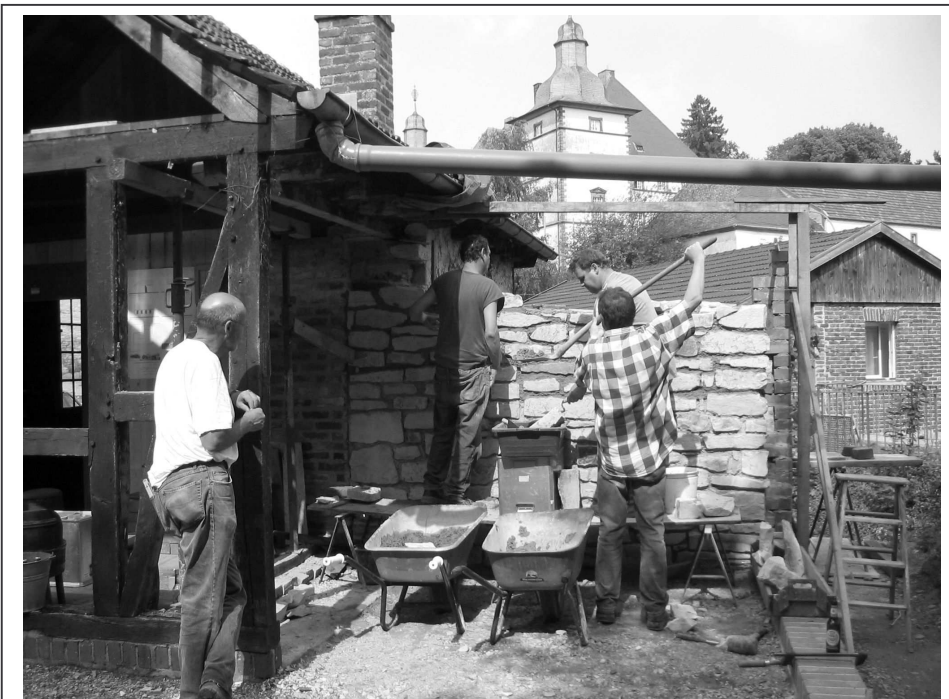
Sommer 2007 – Die Kettenschmiede errichten eine neue Bruchsteinwand
