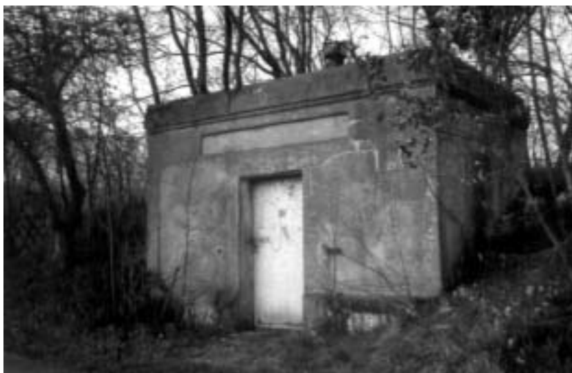
Wasserbehälter im Haselfeld – heutiger Zustand
