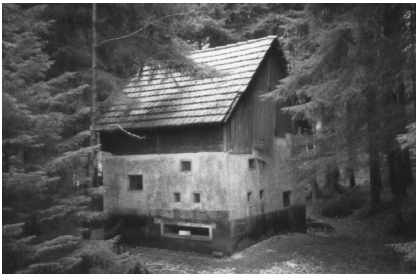
Filterhaus (Enteisenungsanlage) im Allagener Wald
