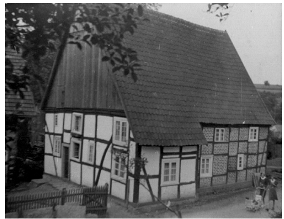
Haus der Hofstätte Fr. Drepper (Rüther) gnt. Schmiedkösters, Mülheim Hauptstraße, in Jahre 1937 (1955 abgerissen)
